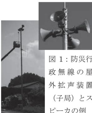
図1：防災行政無線の屋外拡声装置（子局）とスピーカ例
